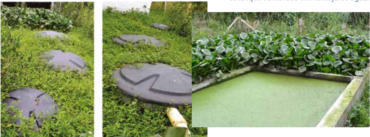
Figura 18. Tratamiento terciario de aguas residuales en la empresa Agrinsa. izquierda: sistema de tanques; derecha: estanque sembrado con lenteja de agua.
