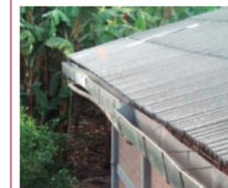
Para la recuperación de las aguas lluvias, se canalizaron 580m lineales, correspondientes a dos galpones, y 92m lineales del total del techo de la bodega para un total de 672 m lineales. Se construyeron e instalaron tanques para almacenamiento de la siguiente manera:
