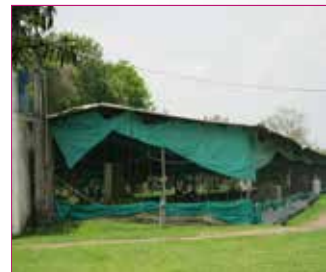
Las cortinas se utilizan como ayuda para conservar el calor, pero mal manejadas entorpecen la ventilación
